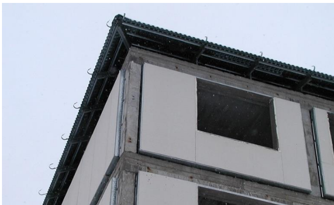
Рис. 3 Заполнение монолитного каркаса стеновыми панелями из ЛСТК
