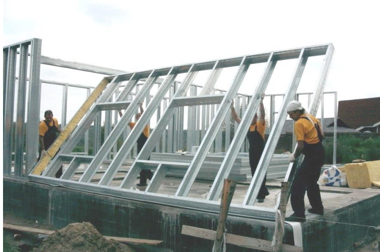
Рис. 2 Монтаж стеновых панелей вручную
