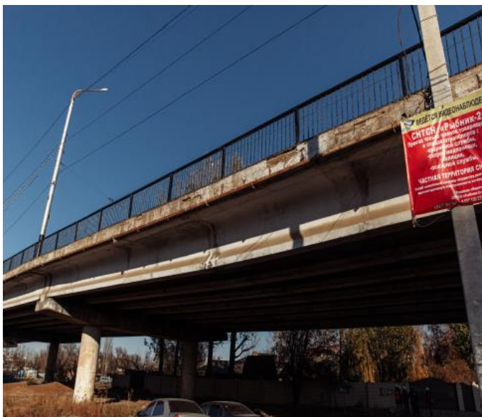
Рис. 6. Прогиб балок пролета №6 до 157 мм.
