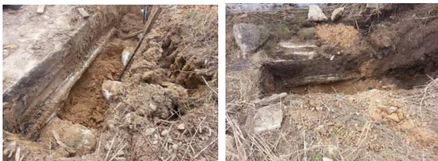
Рис. 3. Общий вид шурфов №1-2
