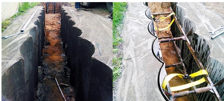
Рис. 2. Схема устройства форшахты [5]
