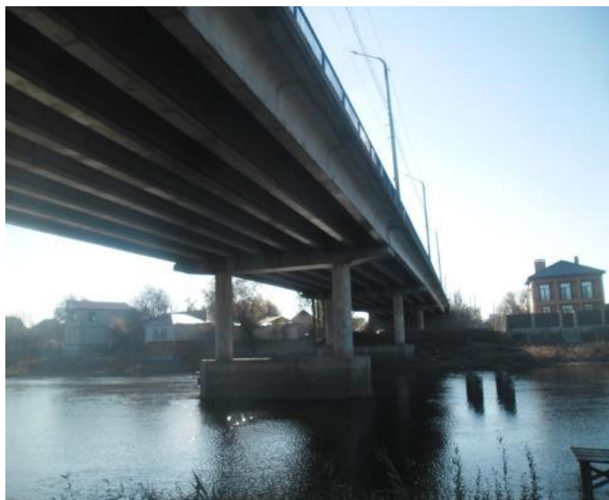
Рис. 4. Вид моста через реку Царёв
