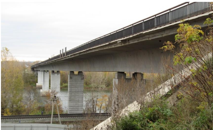
Рис. 1. Общий вид моста.
